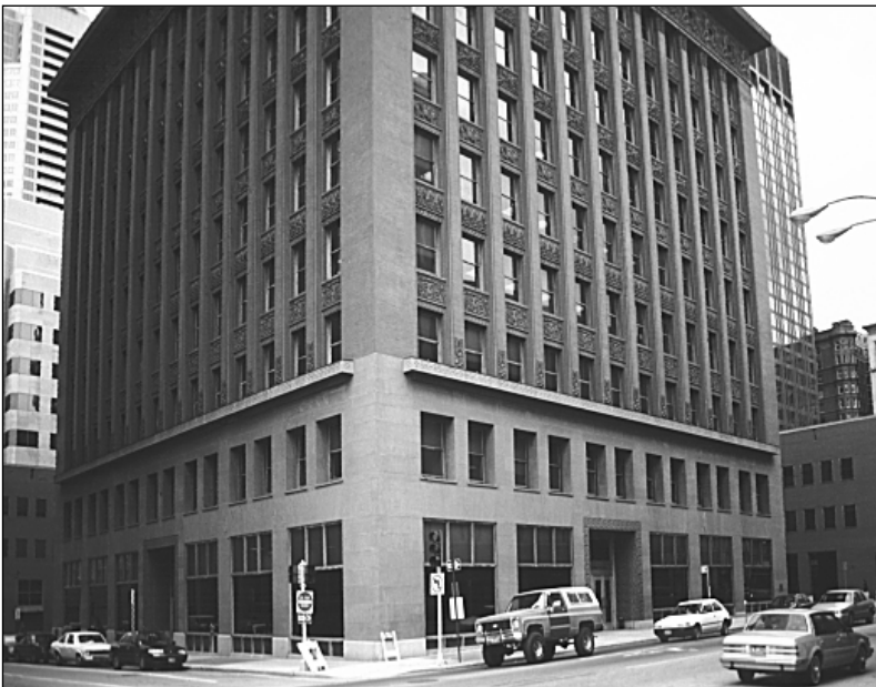
Sullivan & Adler's „Wainwright Building“ aus Sicht des Eingangs
